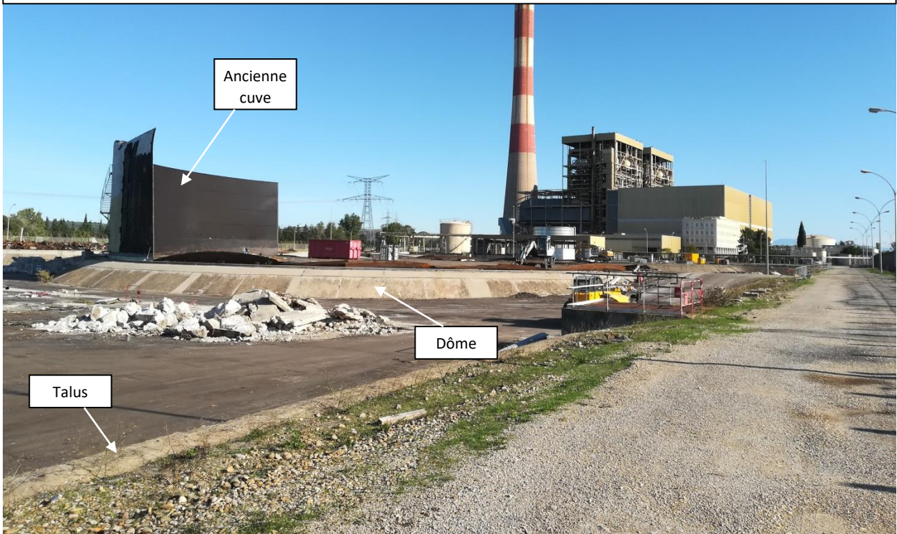
Figure 8- Site en cours de démantèlement – Octobre 2019
